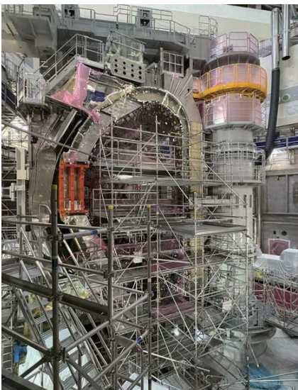
フランスで建設中のイーター
